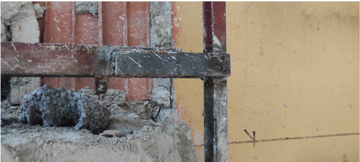
E' già stato posato lo strato isolante su intradossi ed estradossi dei balconi. Pertanto, aggiungendo il copriferro successivamente, lo stesso sporgerà di circa 3 cm (variabili) dal filo dell'isolante, in quanto non è tecnicamente possibile posare una "striscia" di isolante per allineare il filo dell'isolante con quello del copriferro. Si richiede allo Studio Rollino di tenerne conto nel calcolo dei ponti termici.
